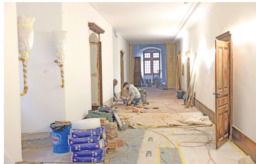
Les ouvriers s'attaquent actuellement à la pose et la réparation des sols.
