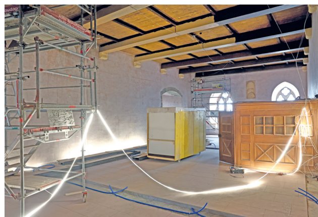
La salle d'Armes accueillera un centre dédié aux arbalètes. Un travail acoustique y sera fait afin d'éviter les échos.
